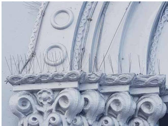
Figura 1. Líneas de hilos de alambre que impide posarse a las palomas.
